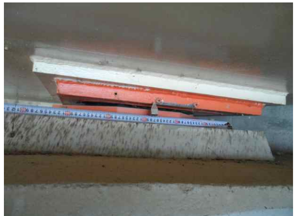
교량 받침 가동량 측정
